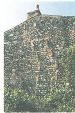
Conduit de cheminée tardu
