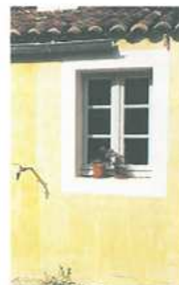
On peut colorer le badigeon avec des pigments afin d'obtenir des effets décoratifs et esthétiques. Avant toute application d'enduit ou de badigeon il est important d'effectuer des échantillons et de prendre le temps de les laisser sécher avant de faire un choix définitif.
