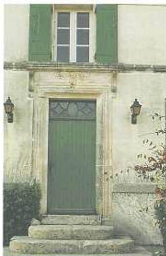
L'imposte vitrée éclaire le couloir. Les menuiseries sont un élément important de la composition des façades charentaises, souvent très simples. Les ouvertures sont presque toutes surplombées et plus petites aux étages.
