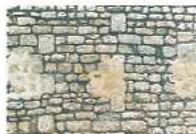
Avant de commencer tout enduit, il est indispensable de faire faire plusieurs échantillons et de les laisser sécher plusieurs jours. Il faut obtenir un échantillon pleinement satisfaisant avant de commencer le travail.
