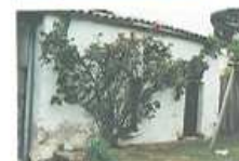
Un rosier habille cette façade très simple.
