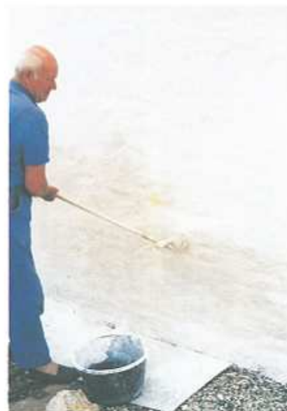
On peut colorer le badigeon avec des pigments afin d'obtenir des effets décoratifs et esthétiques. Avant toute application d'enduit ou de badigeon il est important d'effectuer des échantillons et de prendre le temps de les laisser sécher avant de faire un choix définitif.
